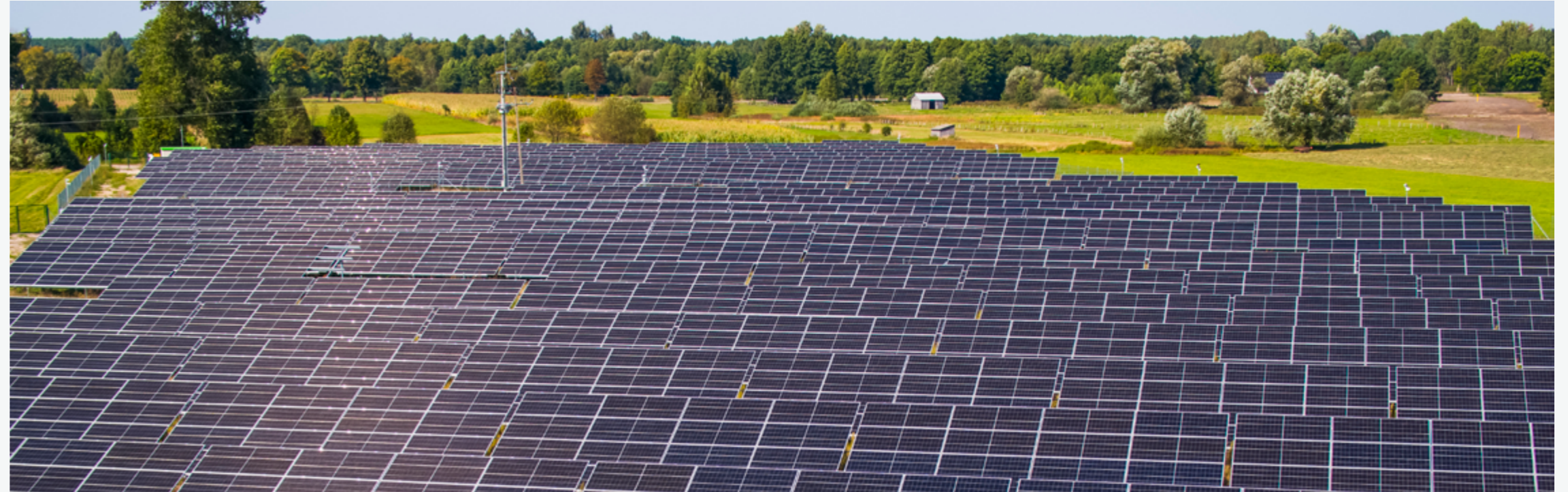
➤ Projekt Solartechnik Żarnowo PV farm
