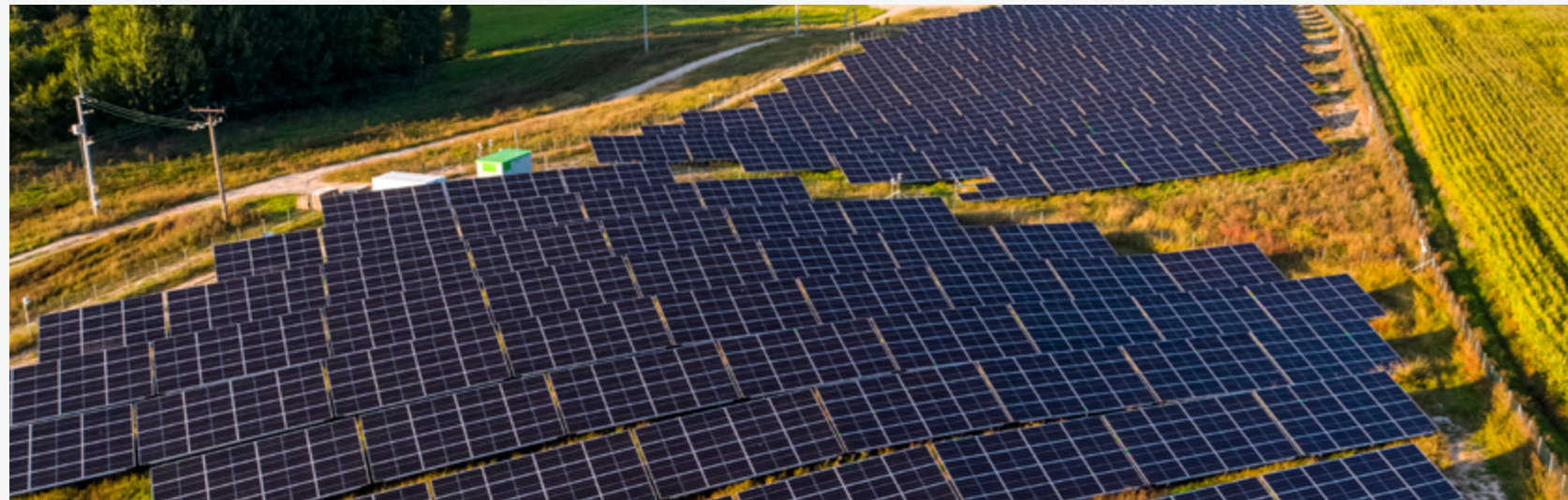
➤ Projekt Solartechnik Żarnowo PV farm
