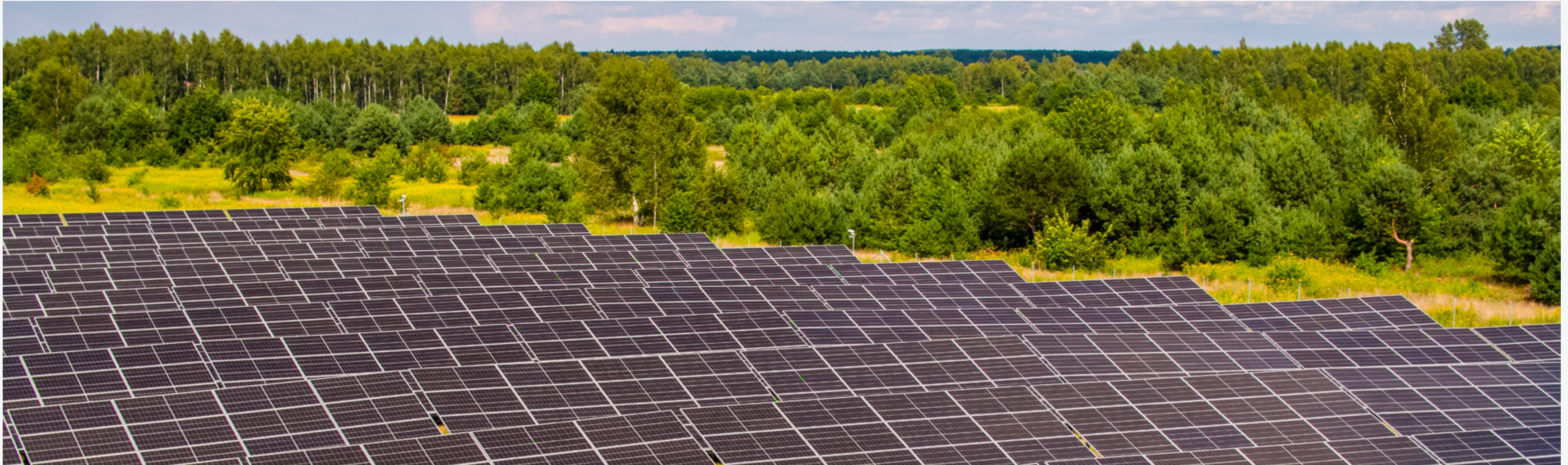
➤ Projekt Solartechnik Biały Bór solar PV farm
