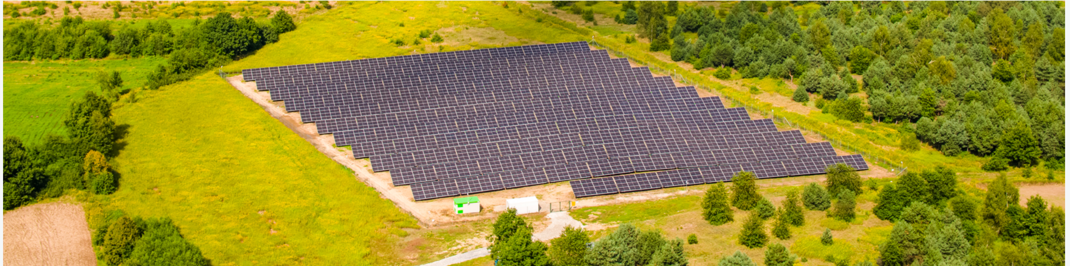
➤ Projekt Solarteknik Biały Bór solar PV farm
